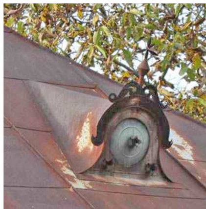
Jellemző tetőnyílások, - ökörszemablakok bádogos munkával kialakítva
