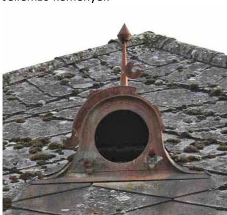
Jellemző tetőnyílások, - ökörszemablakok bádogos munkával kialakítva
