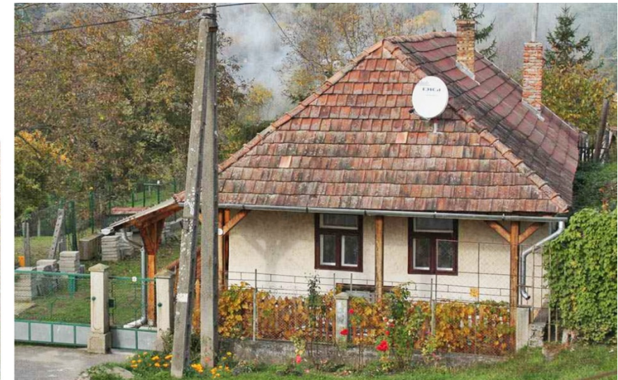
Kontyolt nyeregtetős épület cserépfedéssel, elülső és oldalsó fa szerkezetű tornáccal
